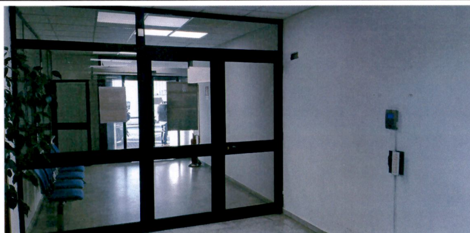
VISTA UFFICIO PIANO TERRA Lato Sarzana
