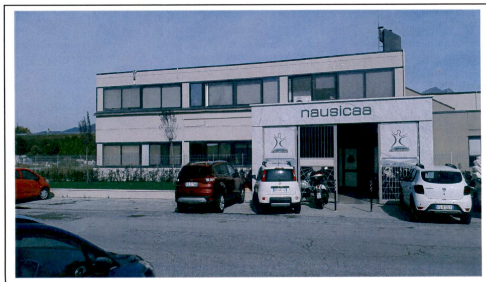
VISTA ESTERNA Ingresso Lato mare
