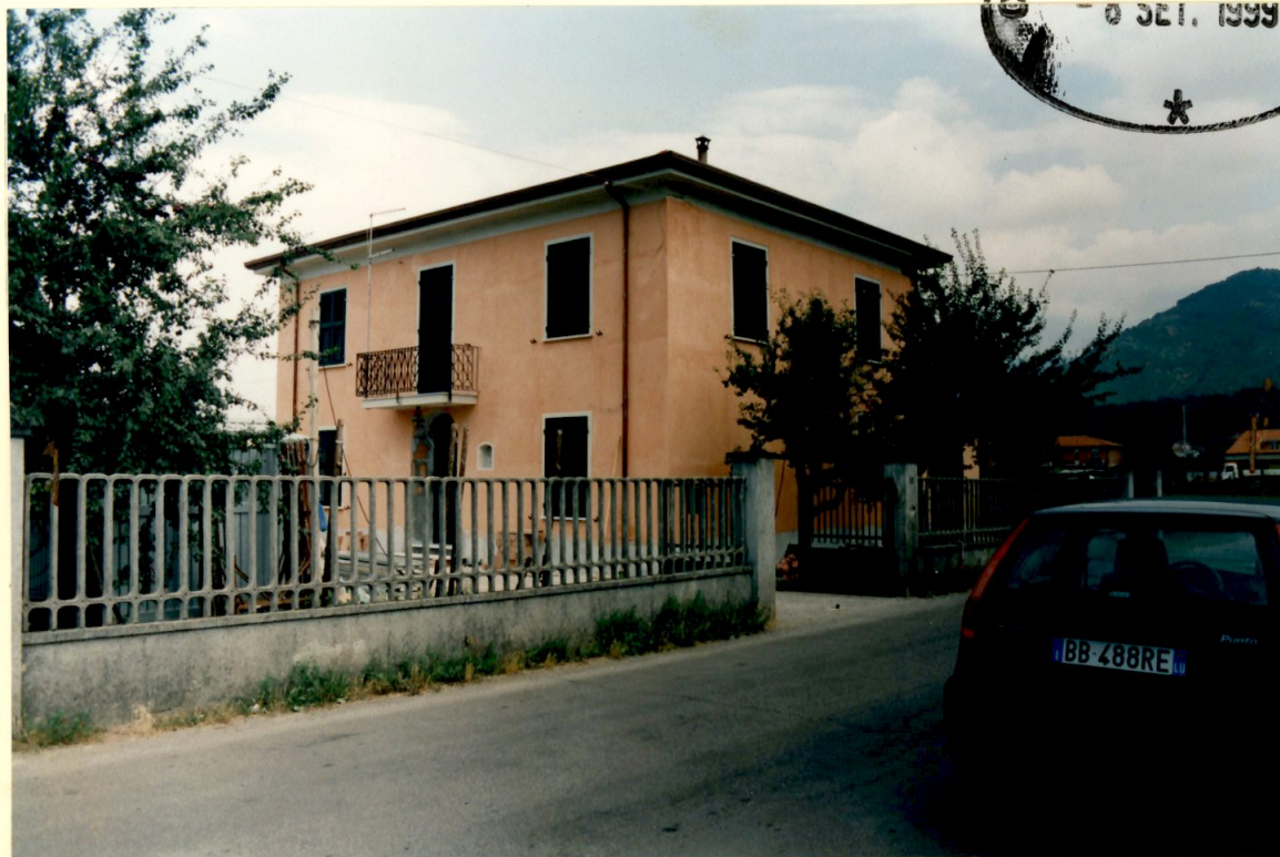
3 - VISTA LATO SUD-EST
