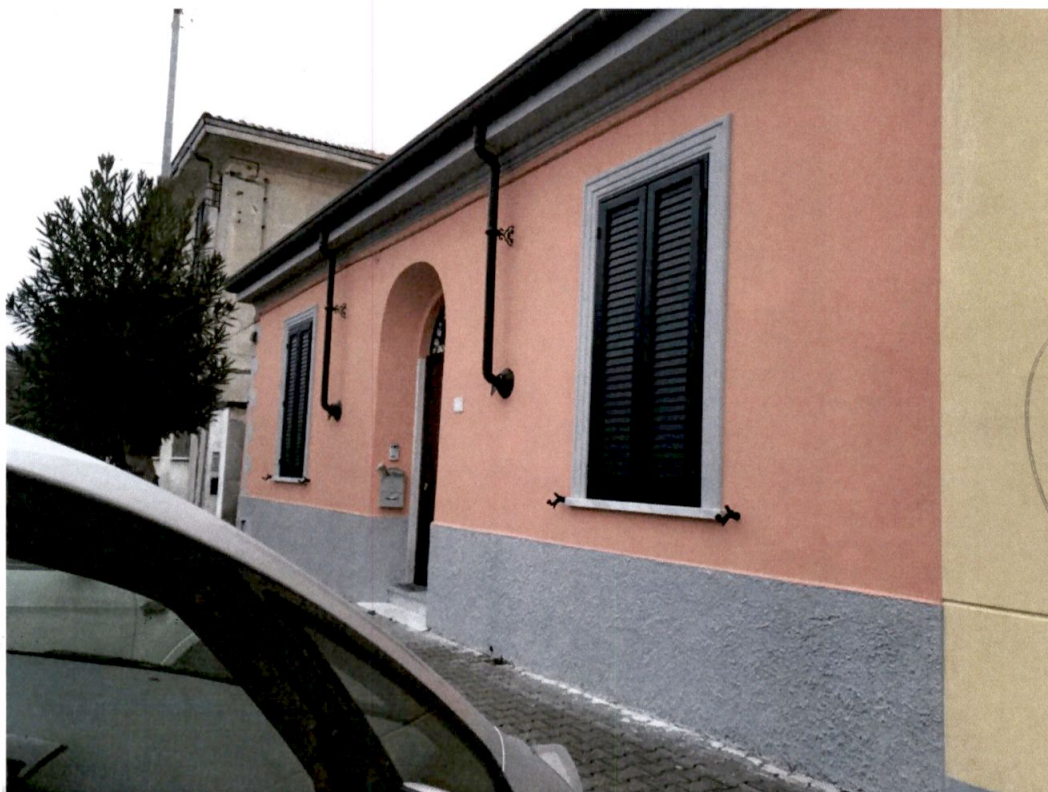
Foto 3: vista dal marciapiede di Via Firenze
