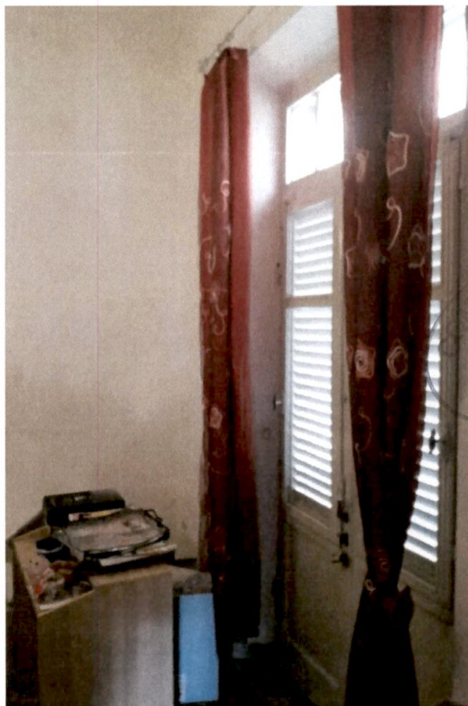
Foto 7: vista interna della portafinestra in soggiorno
