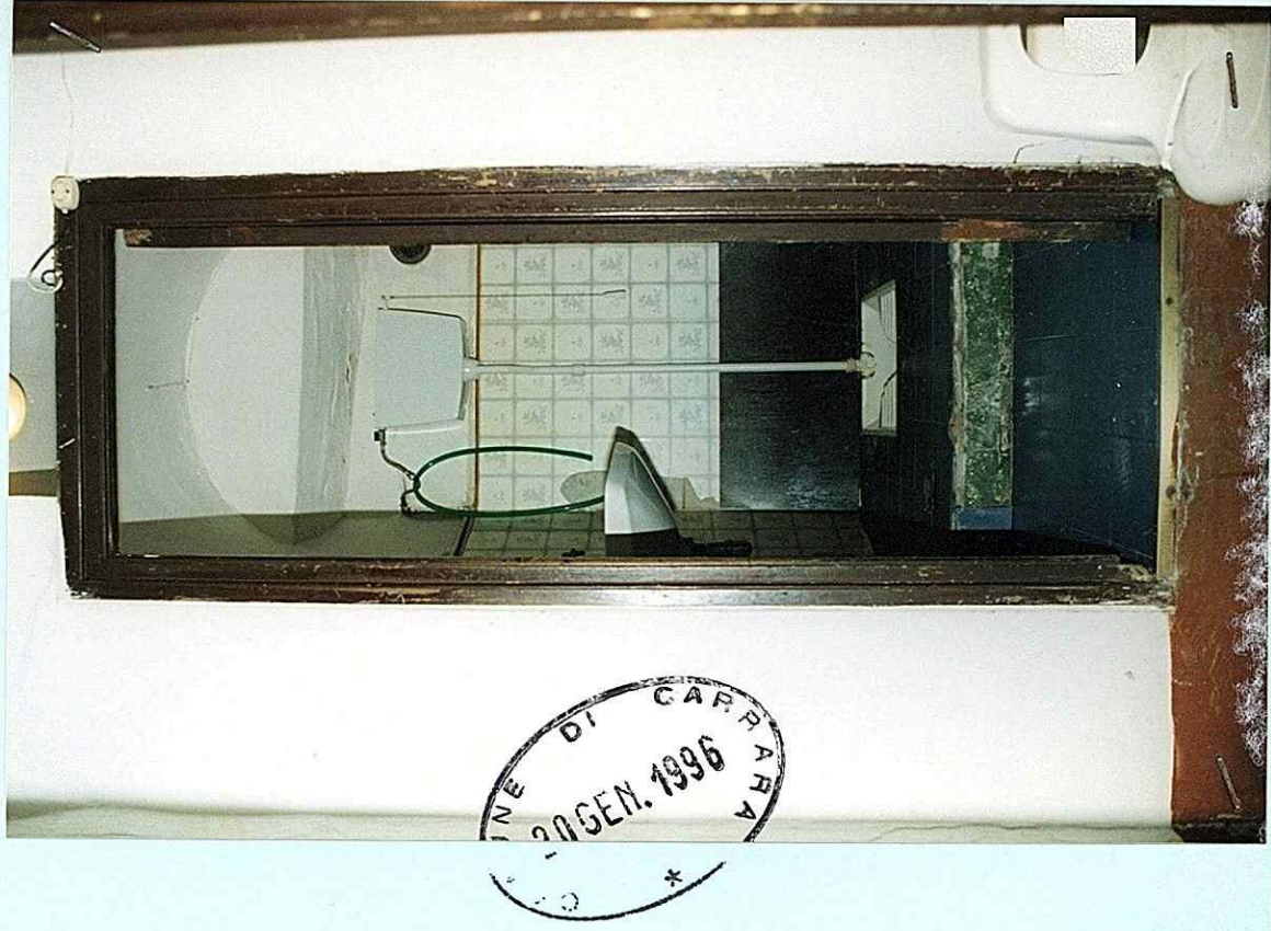
FOTO 2 DEMOLIZIONE SERVIZI IGIENICO
