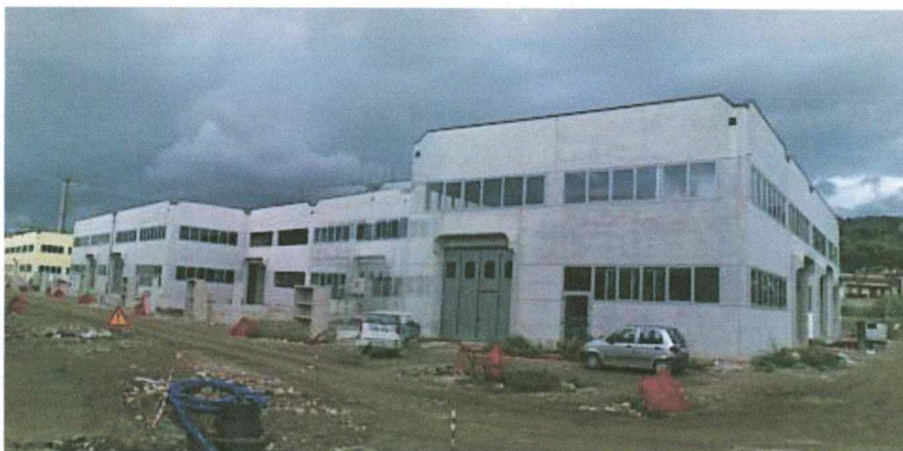
Capannone F lato mare
