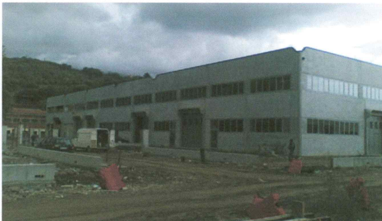
Capannone H lato Sarzana
