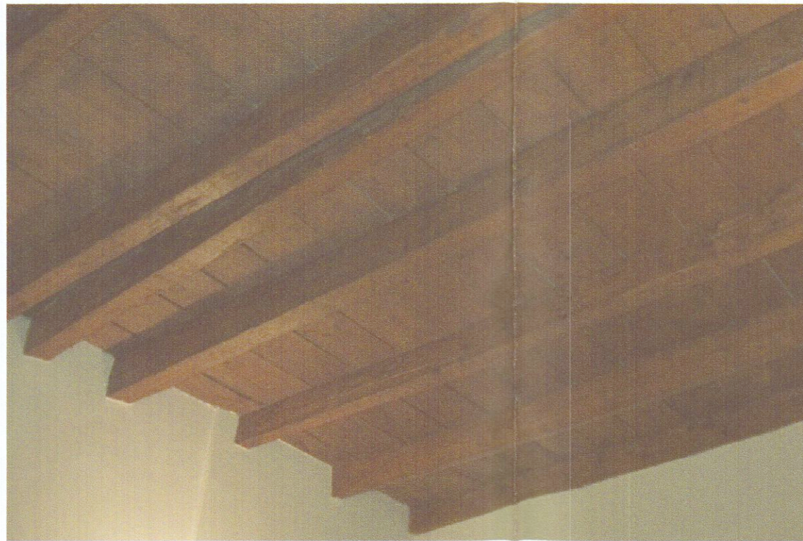
soli realizzati in legno armato tipo armalam
