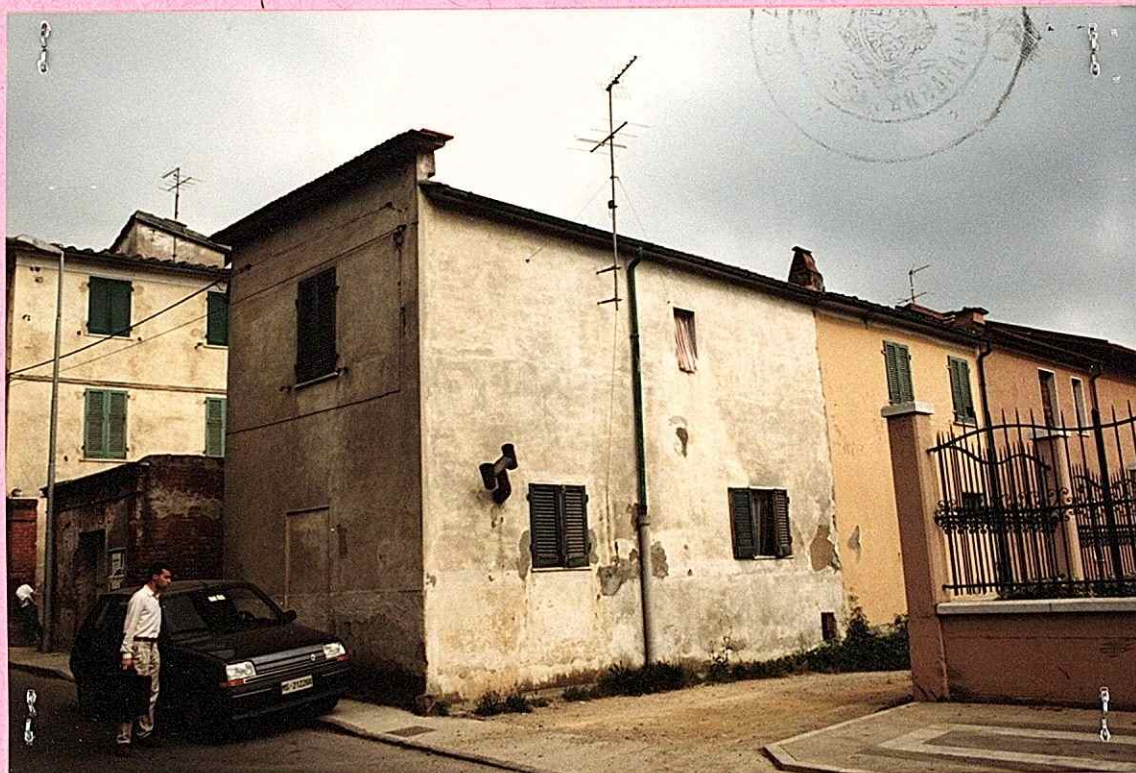
Prospetto lato Sud-Ovest
