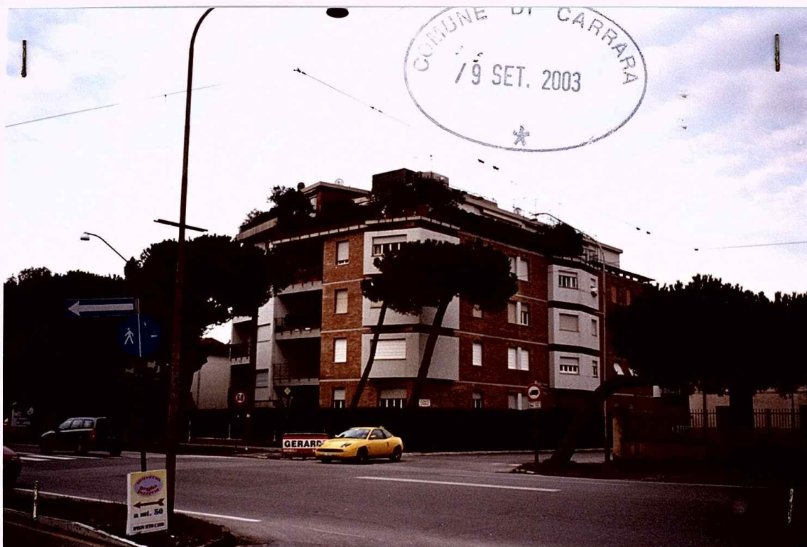
FOTO 1 (vista d'angolo Viale Colombo)
