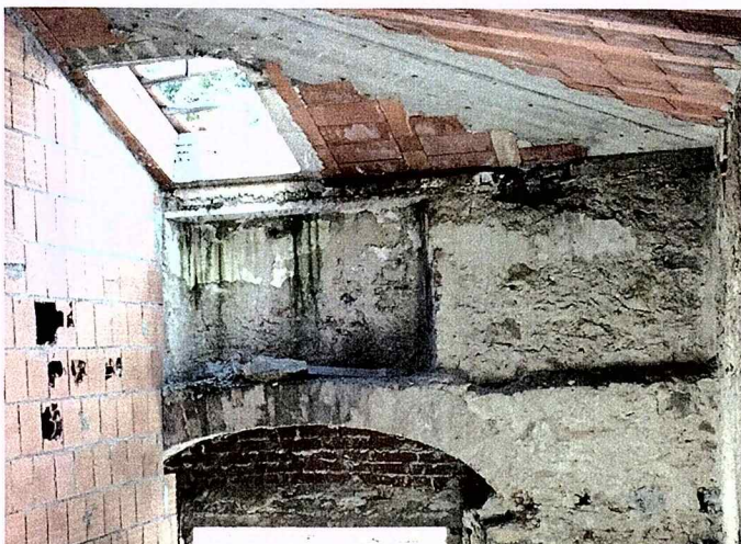
Vista interna della finestra tamponata
