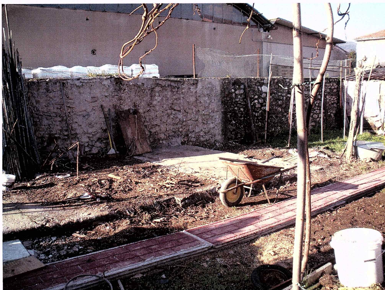
Foto 2: Muro di recinzione ove si costruirà la legnaia
