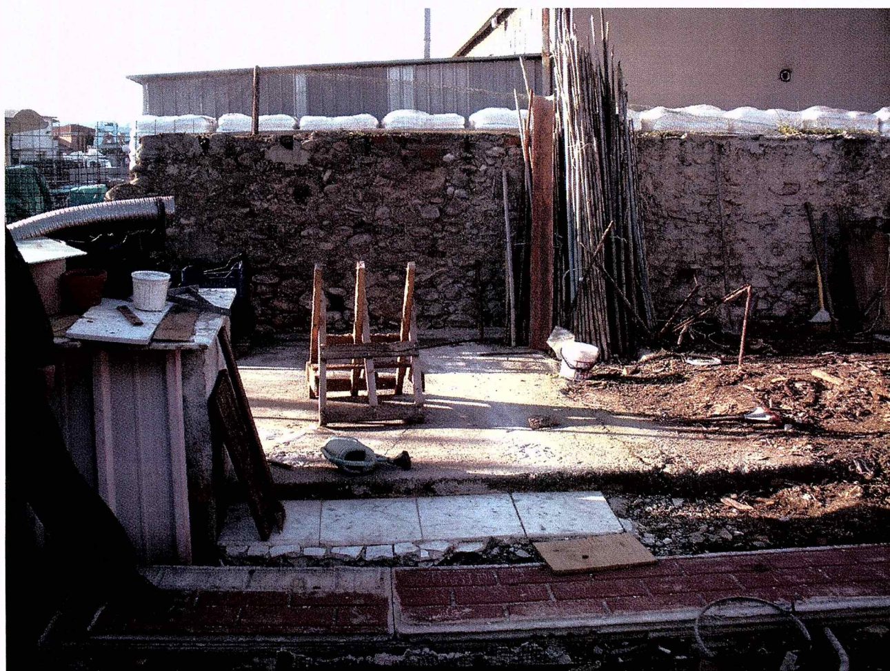
Foto1: Muro di recinzione ove si costruirà il capanno attrezzi
