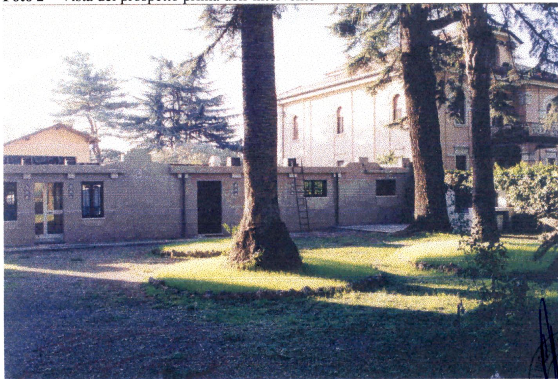
Foto 2 – Vista del prospetto prima dell'intervento
