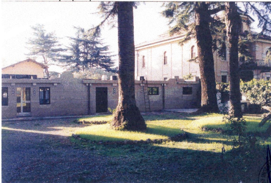
Foto 2 – Vista del prospetto prima dell'intervento
