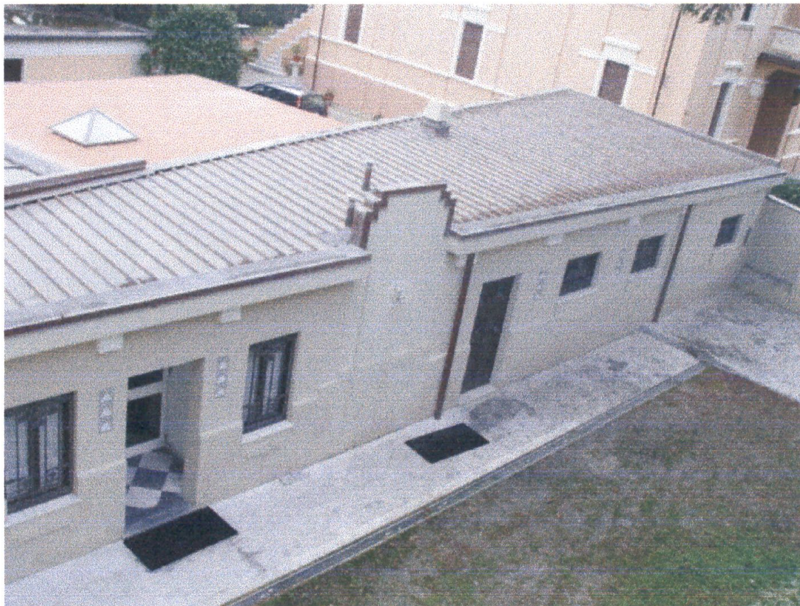
Foto 5 – Vista della copertura post abuso
