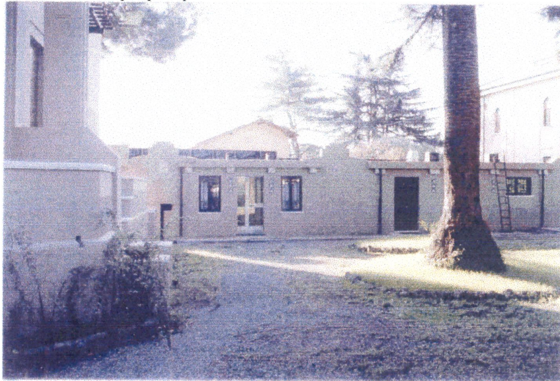
Foto 1 – Vista del prospetto prima dell'intervento
