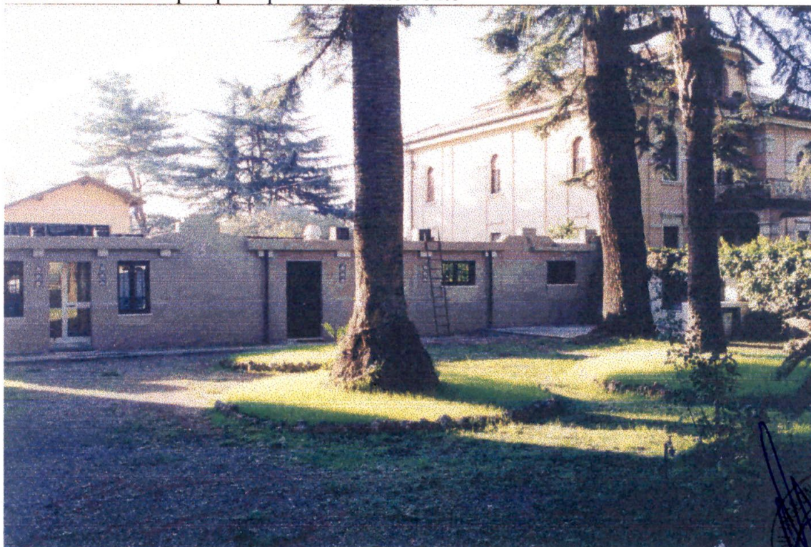
Foto 2 – Vista del prospetto prima dell'intervento
