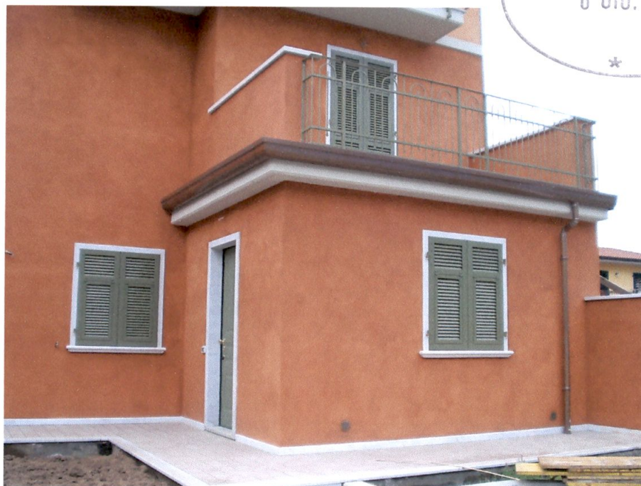
4 – prospetto est – particolare
