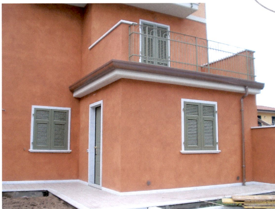
4 – prospetto est – particolare
