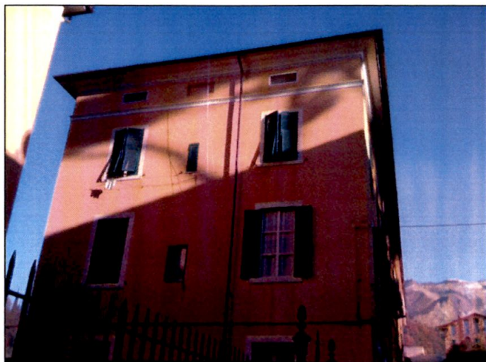
Fronte lato sud
