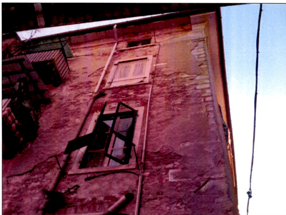
Particolare del prospetto ovest oggetto del restauro degli intonaci e delle tinteggiatura.
