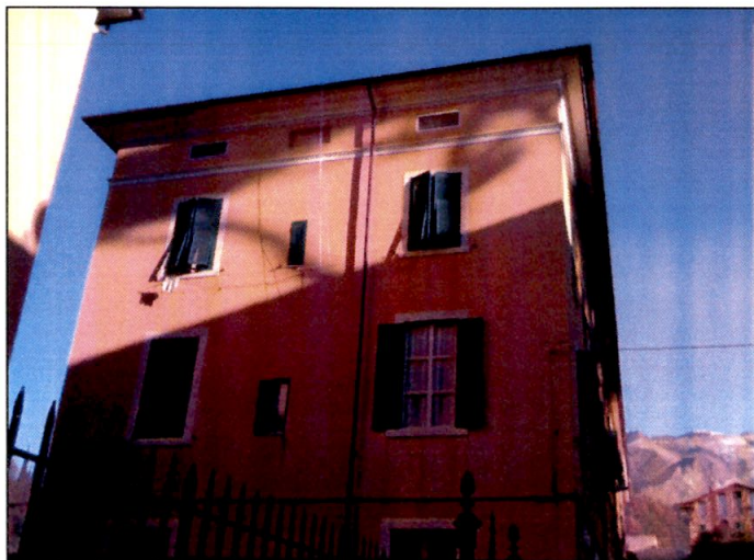
Fronte lato sud
