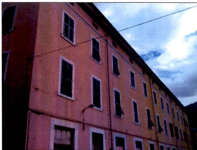
Fronte lato est
