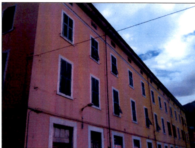
Fronte lato est
