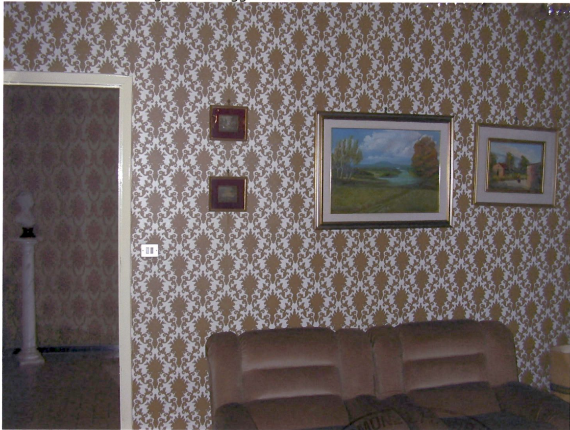
Foto 3 Tramezzatura tra ingresso e soggiorno da rimuovere
