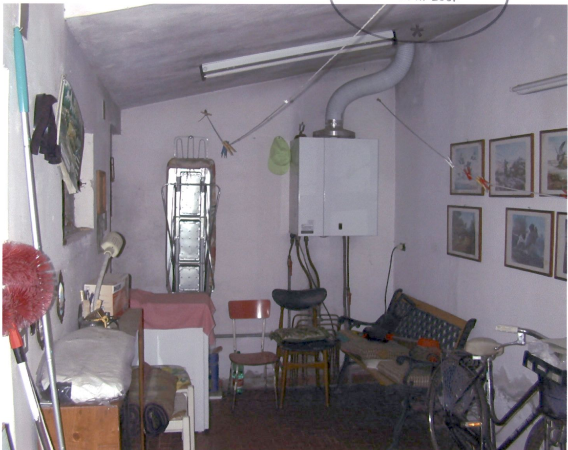
Foto 4 Interno locale cantina
