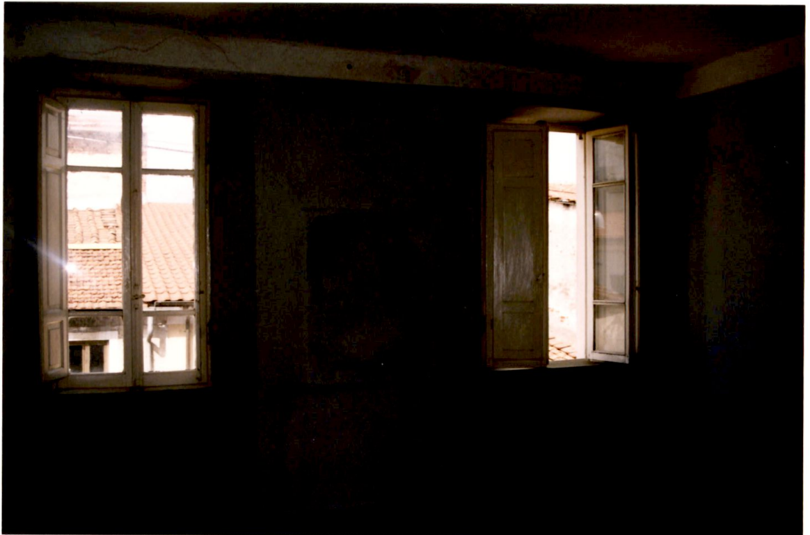
Particolare interno piano secondo vano lato nord
