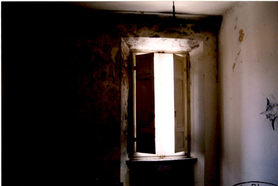
Particolare interno piano terzo vano lato nord
