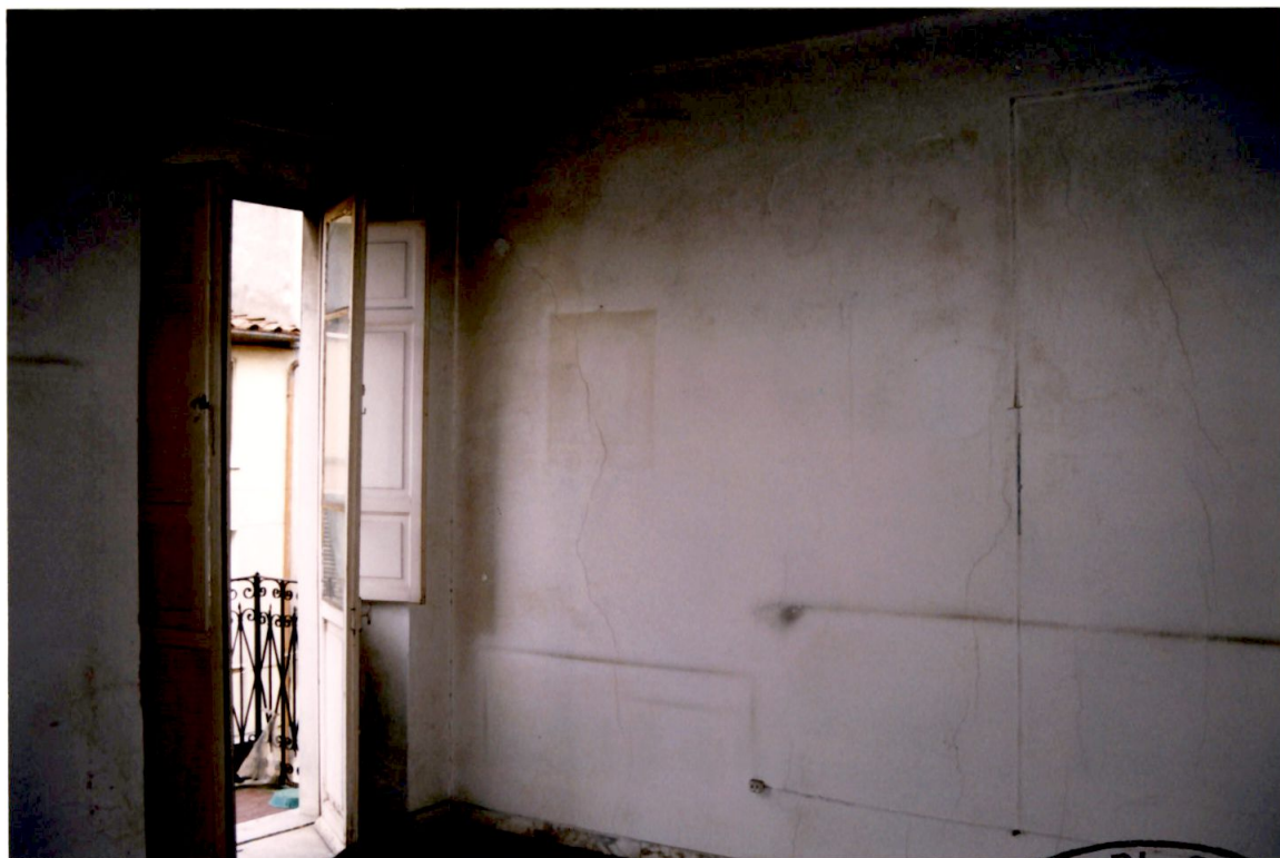
Particolare interno piano primo vano lato nord
