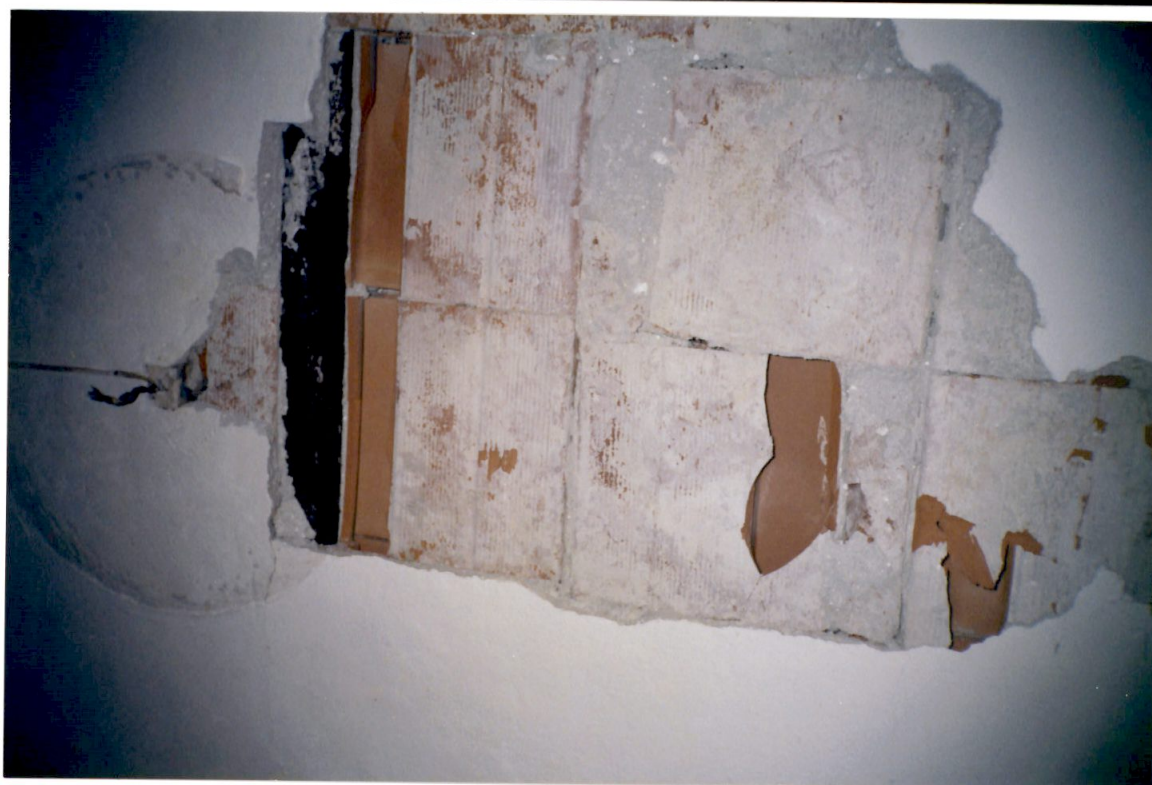
Vista particolare solaio piano primo vano lato nord ↑↑
