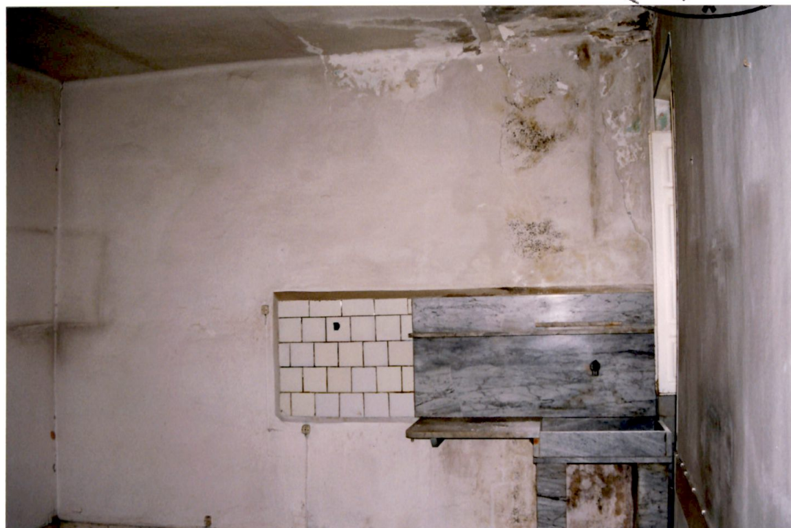
Particolare interno piano primo vano lato sud
