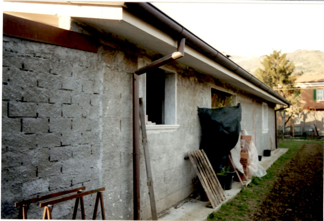
FOTOGRAFIA N.1 : Intonacatura esterna di tutto il fabbricato con intonaco a base di calce compresa arricciatura e tinteggiatura di colore giallo.
