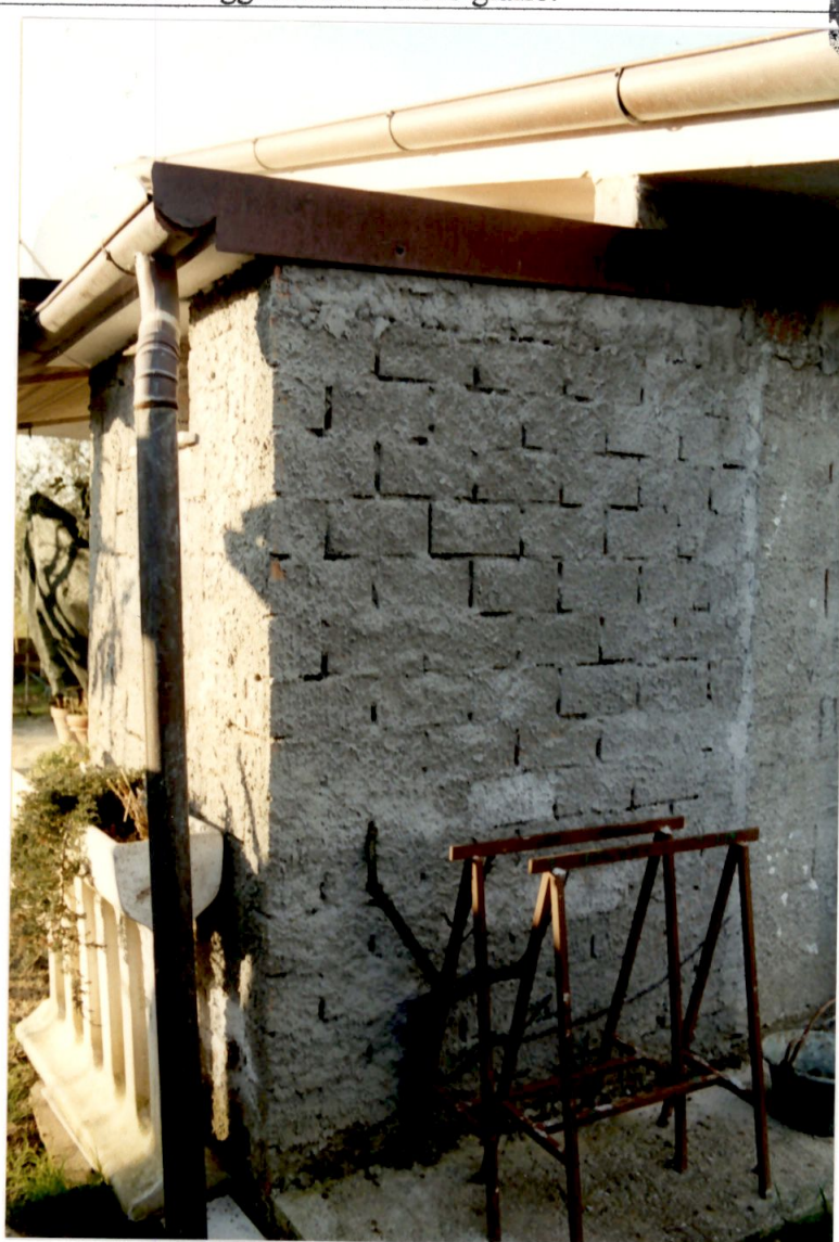
FOTOGRAFIA N.2 : Demolizione completa del locale ad uso servizio igienico posto esternamente alla sagoma del fabbricato lato mare.
