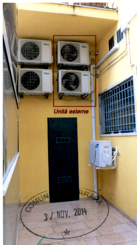
Foto n. 21 – Indicazione del posizionamento delle due unità esterne esistenti
