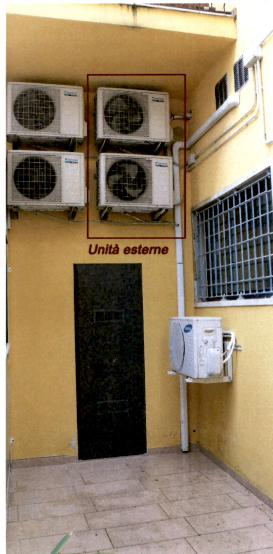
Foto n. 21 – Indicazione del posizionamento delle due unità esterne esistenti
