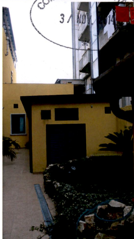
P.E. Foto n. 19 – Cortile interno
