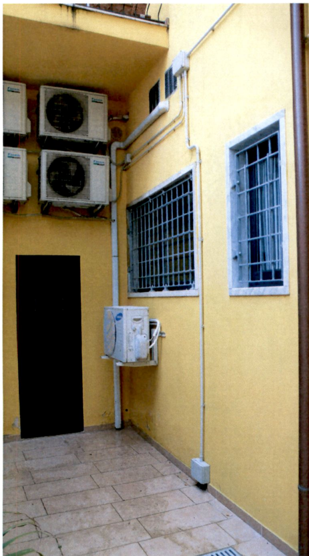
Foto n. 20 – Individuazione delle finestre rispettivamente del bagno e della zona reception nella parte in ampliamento
