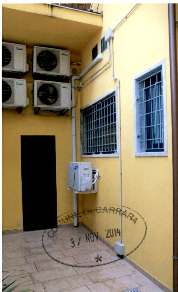
Foto n. 20 – Individuazione delle finestre rispettivamente del bagno e della zona reception nella parte in ampliamento
