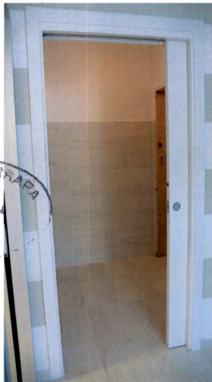
P.E. Foto n. 17 – Attuale Anti-bagno (4);
