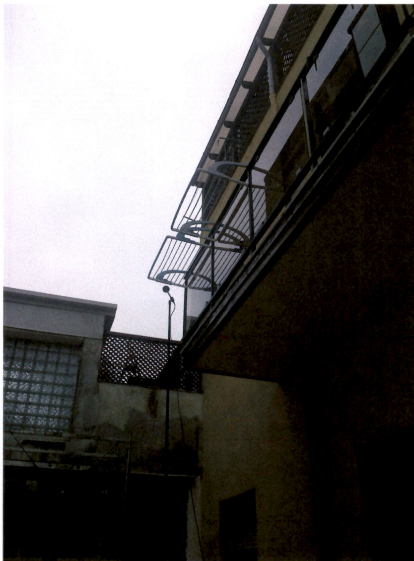
Fig. 3 Recettore R3 Corte interna
