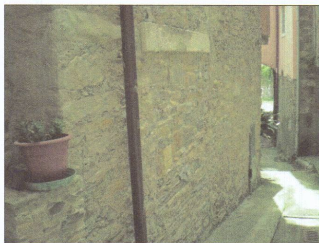
ripresa prospetto ovest
