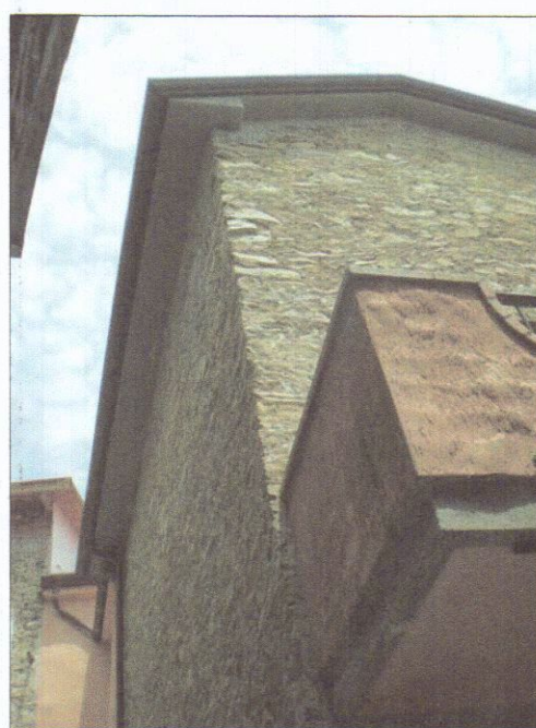
ripresa prospetto sud/ovest
